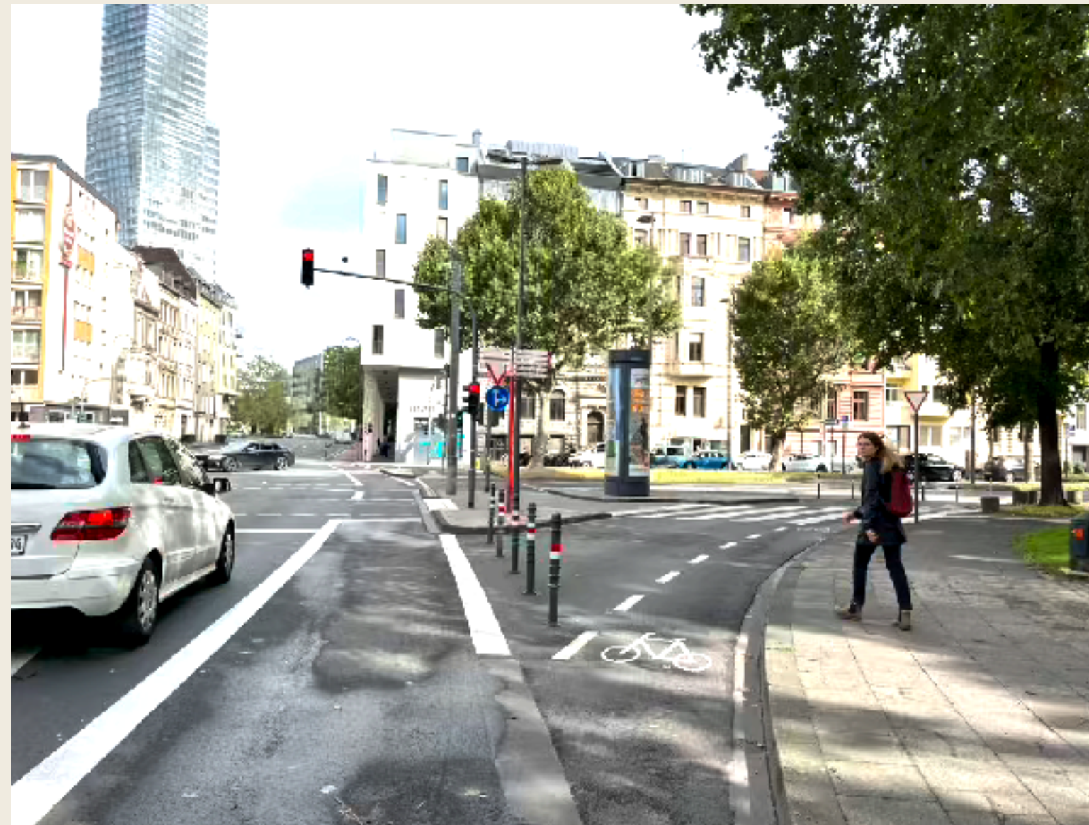
Rückbau von Abbiegespuren
